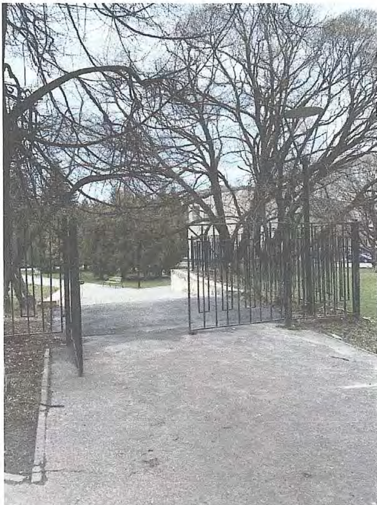
Фото № 1.1. Входы (входы) на территорию
