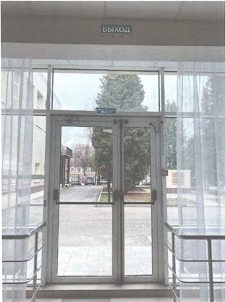
Фото № 3.5. Пути эвакуации (в т.ч. зоны безопасности)
