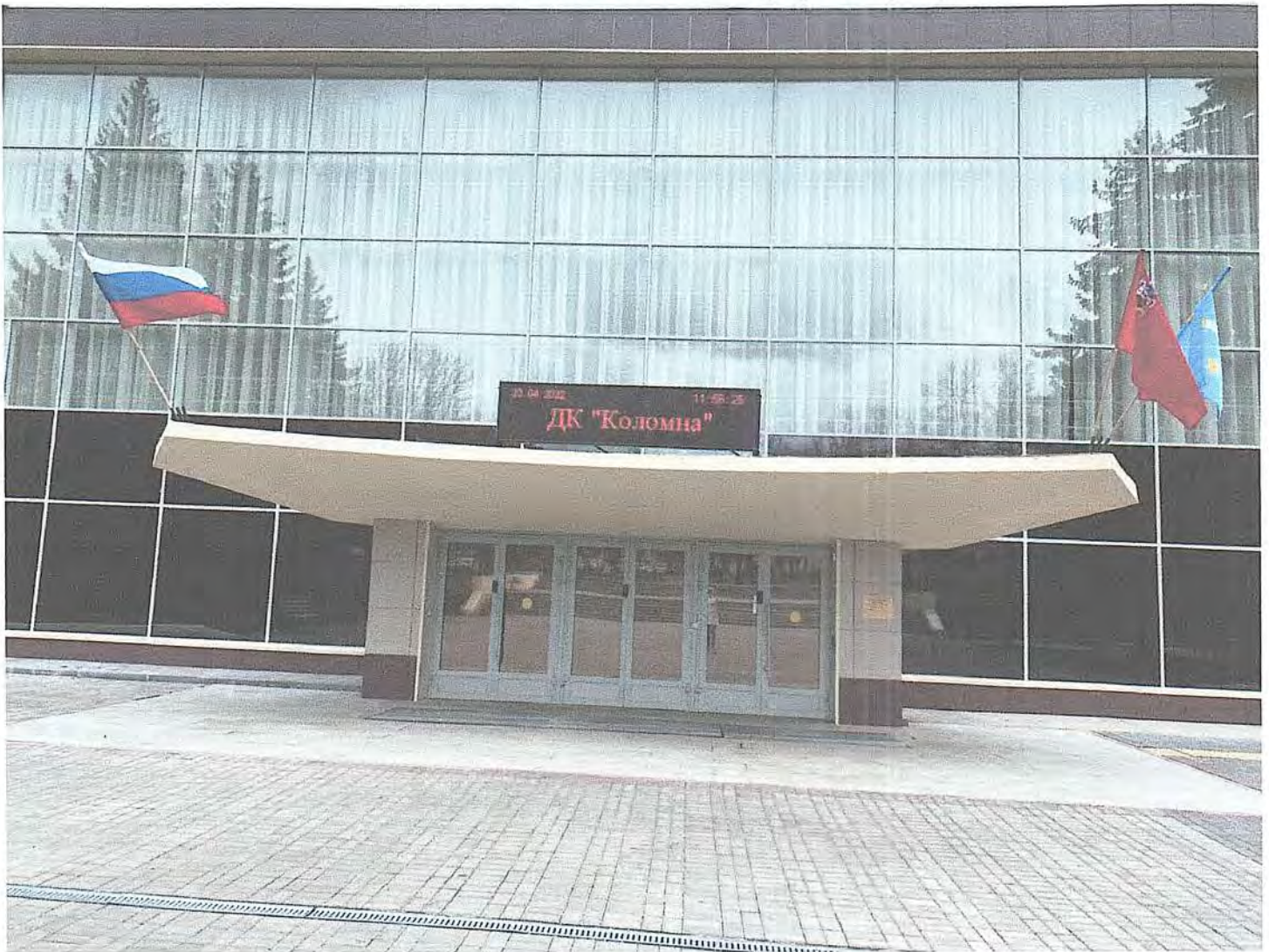
Фото № 2.1. Входная площадка (перед дверью)
